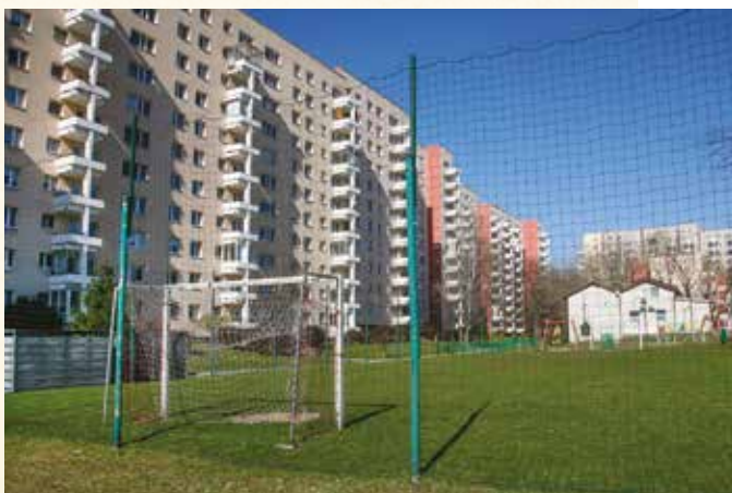
Boisko przy ul. Sonaty poddane renowacji
